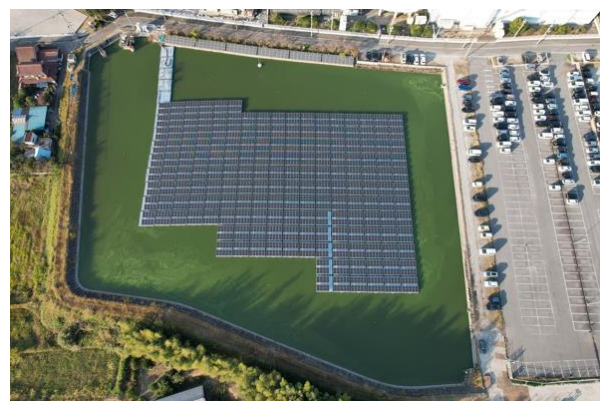
ため池を活用した水上太陽光発電所
