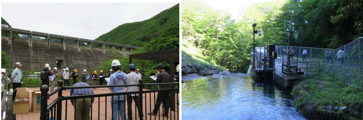
▲ダムの放流を利用している横川蛇石発電所(左)、貯水を約150m高い上流で行い、高低差を利用した駒ヶ根高原水力発電所、環境負荷も低減している(右)
