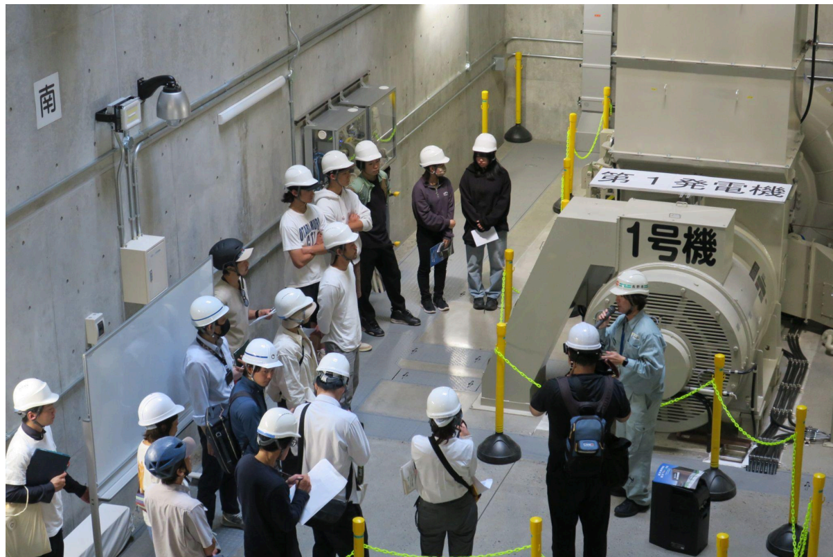
▲灌漑用水を利用した西天竜発電所見学の様子
