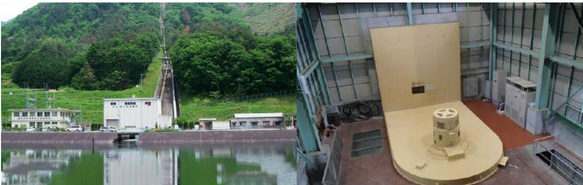
▲ 柚ノ木発電所の様子
